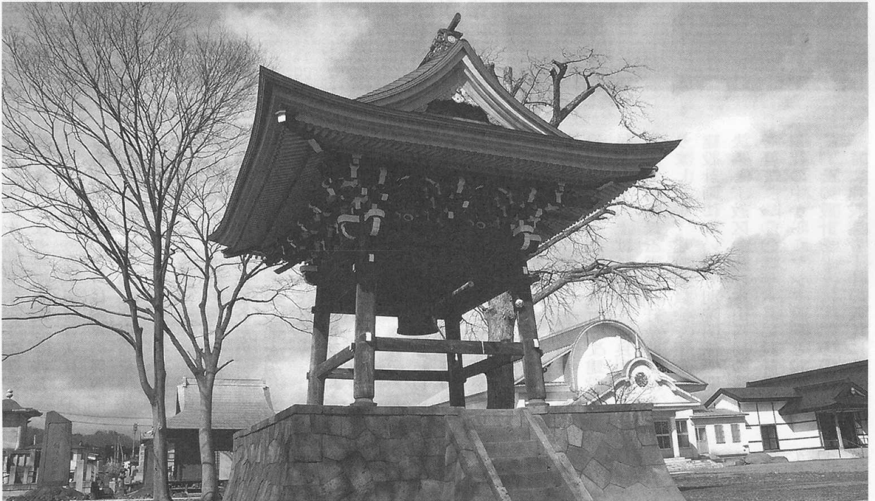
御修復された高田別院鐘楼
