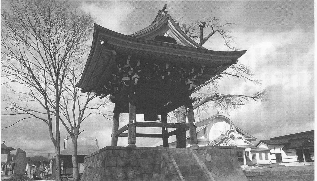
御修復された高田別院鐘楼
